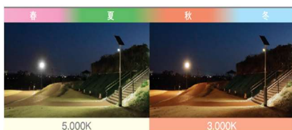
ソーラーLED照明(左)と色温度切り替え例
