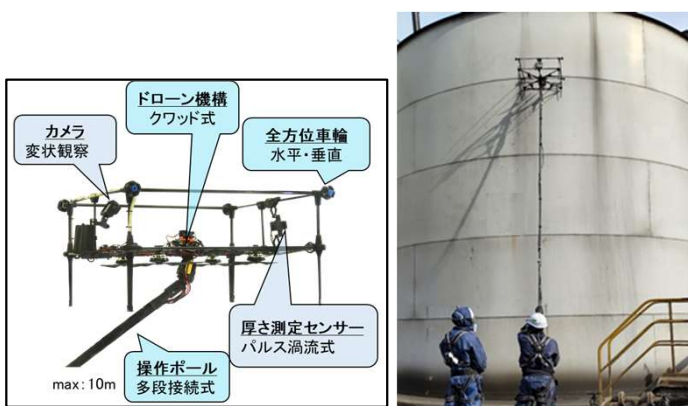
ポール型点検ロボットとタンクの点検の様子
