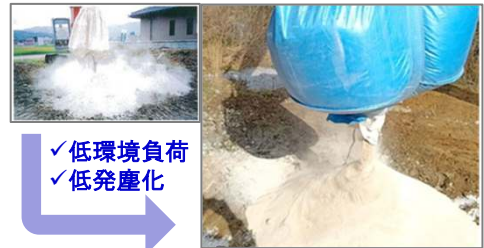
防塵処理品の施工の様子
