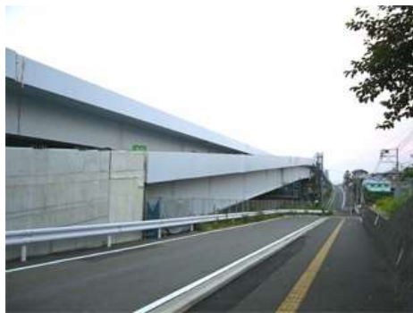
プラズワイヤー工法施工例 福岡高速5号線 梅林ランプ橋梁部
