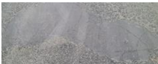
図5 表層材試作品施工後の路面状況
