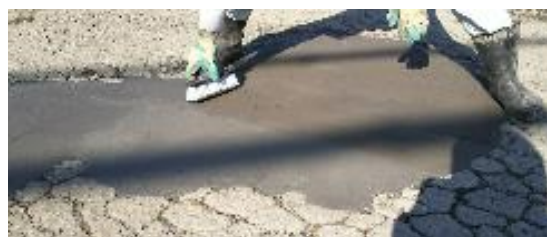
図4 表層材試作品の塗布・仕上げ状況
