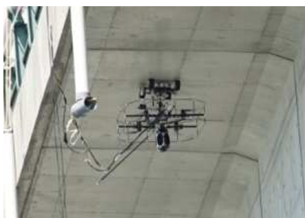
図4 点検中の橋梁検査用ドローン
