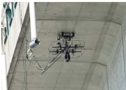
図4 点検中の橋梁検査用ドローン
