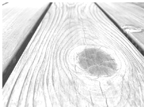
図1 10年間石けん塗料液でメンテナンスした屋外に設置したウッドデッキ（上）と木材表面（下）
