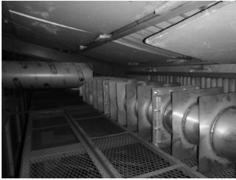
図2 排熱回収管
