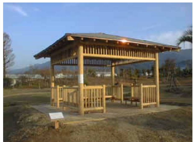
写真 - 1 屋外構築物 (東屋)
